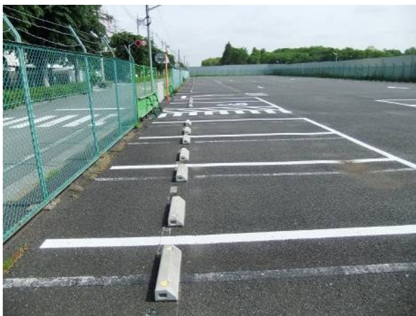
雨水本管、汚水本管施工前
