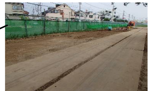
排水工事(埋戻し完了)
