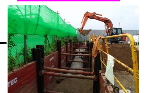
排水工事(雨水管布設工事)
