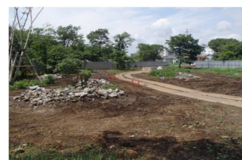
構造物撤去工事
