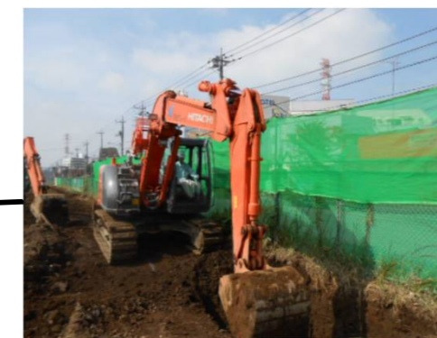
雨水管布設工事(掘削状況)
