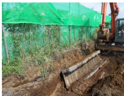
構造物撤去状況
