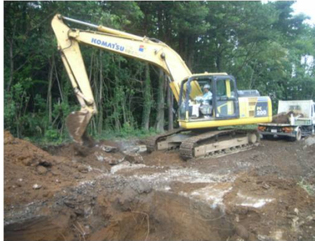
構造物撤去工
