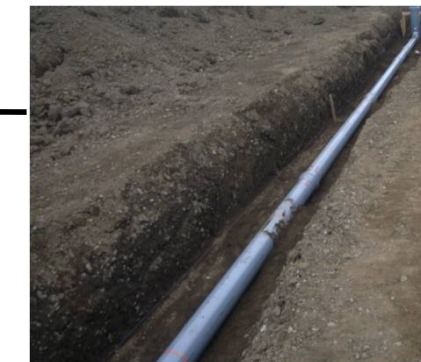
管布設状況(污水)
