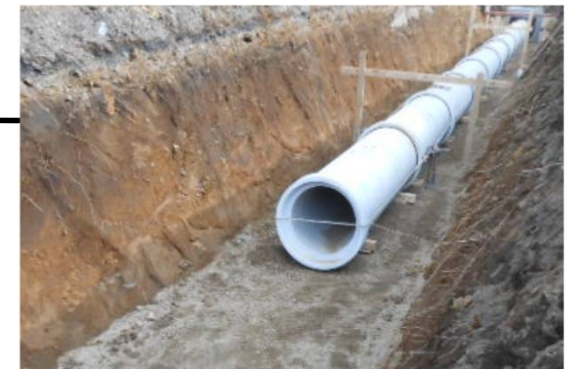
管布設状況(雨水)
