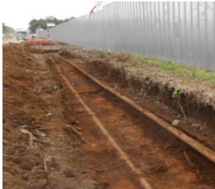
構造物撤去工
