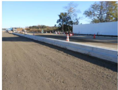
中央分離帯設置完了
