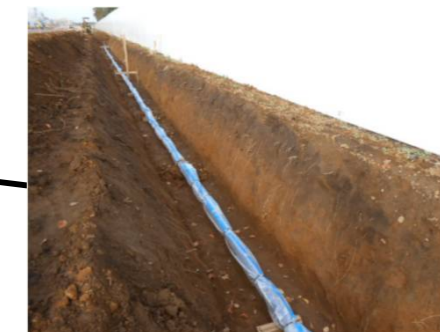
水道管布設(配管状況)
