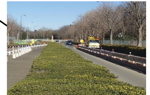
都道153号線規制帯設置状況
