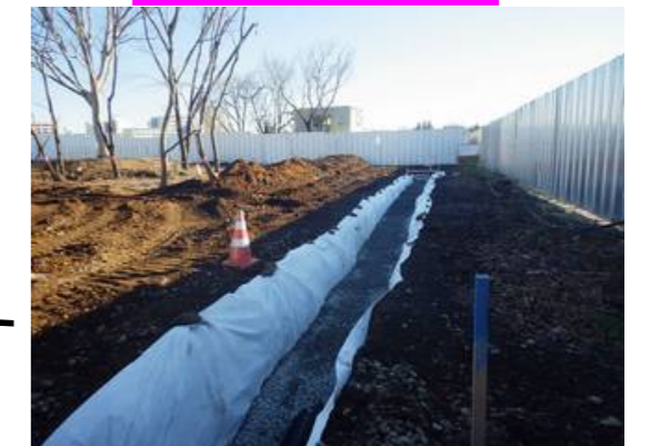
浸透管設置状況
