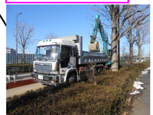
都道153号線(掘削状況)
