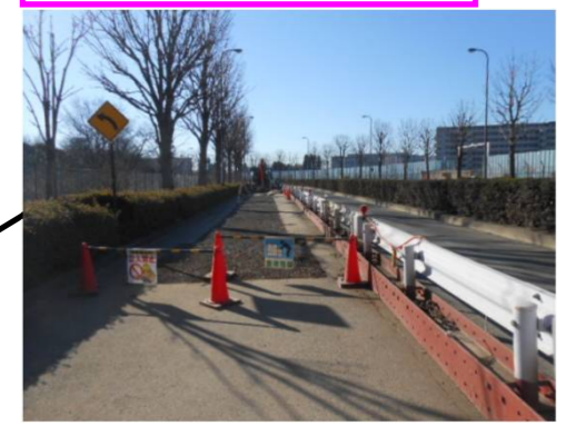
都道153号線(舗装撤去完了)
