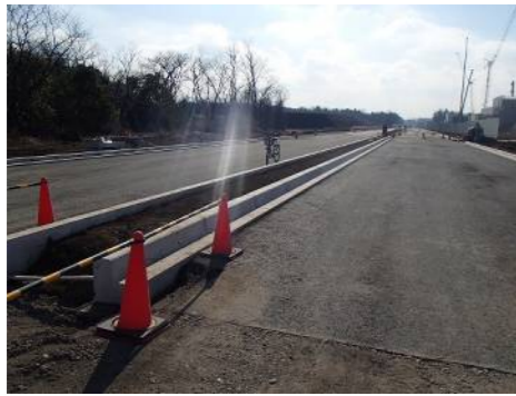
道路舗装状況
