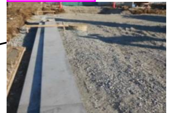
街渠施工状況
