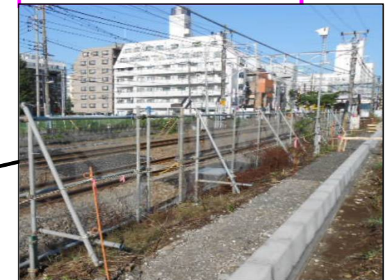
ブロック設置状況 (JR沿い)
