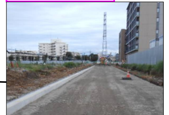
区-2 路盤工完成状況
