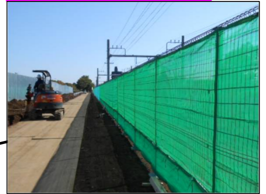
U字側溝掘削状況 (JR沿い)
