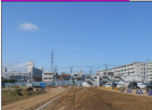
防災施設工(小堤)
