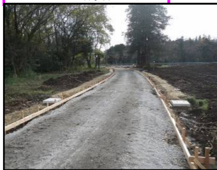
コンクリート舗装施工状況
