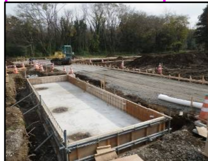
トイレ基礎施工状況
