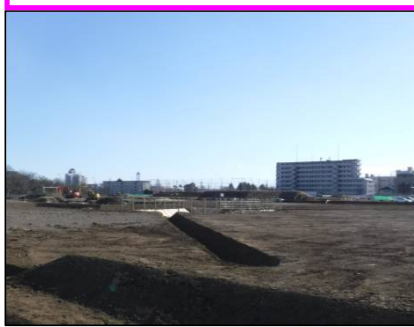
防災施設工(素掘水路)設置完了
