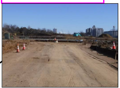
交通広場(路床工)施工状況
