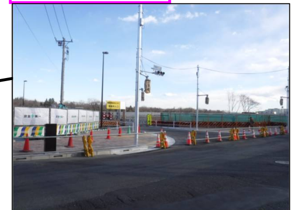
交差点工事(完了)
