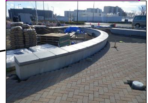
ベンチウォール完了・舗装施工状況
