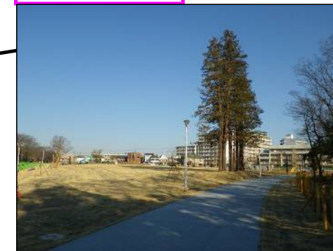
舗装・張芝(完了)
