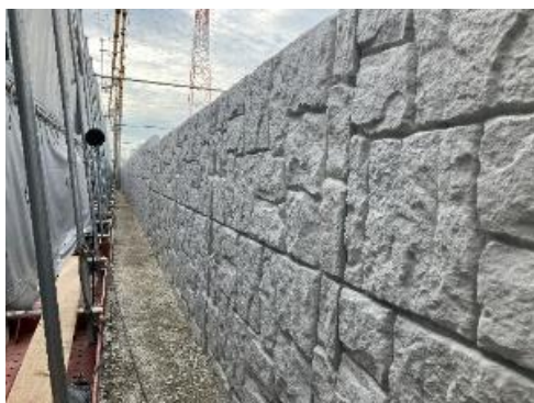
写真①：C工区擁壁設置
