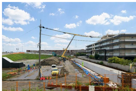
写真②：D工区雨水貯留槽設置
