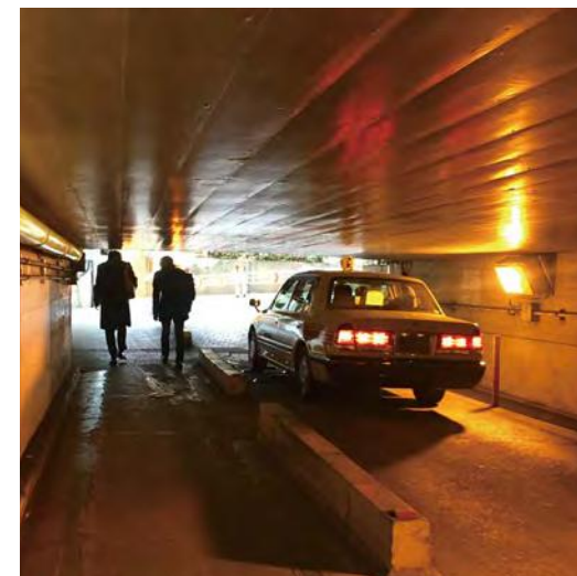
高輪橋架道橋
