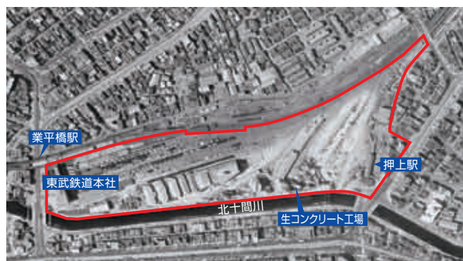
貨物ヤードとコンクリート工場の様子 [1963(昭和38)年]
