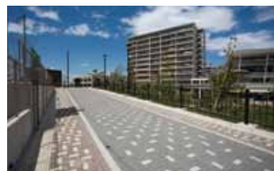
⑤緑豊かな市民広場の左手に新設した、緩やかなスロープの区画道路3号。
