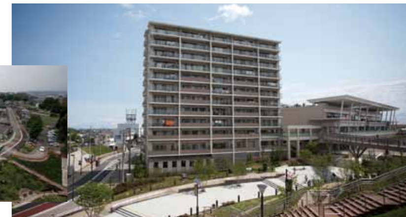
⑧ 眼下には市民広場が、遠くには秩父連峰が広がり、開放感にあふれた狭山スカイテラス。
