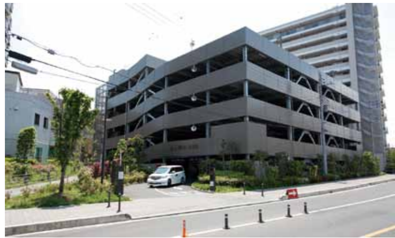
③ 157 台の駐車ができる狭山市駅西口駐車場。
