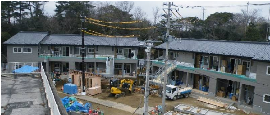
（写真）完成に向けて急ピッチに工事が進む浦田野々島災害公営住宅
