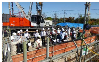
諏訪団地建替工事の現場見学
