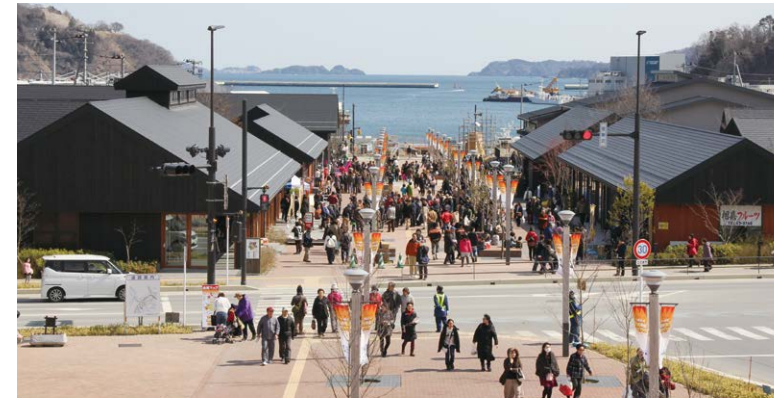
女川駅周辺は、商業施設、観光施設が、海へと続く軸線上に計画的に配置され、住民や観光客が集う賑わい空間が形成されている。
