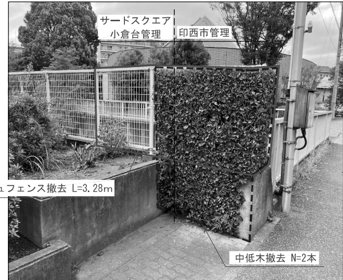
写真① 中低木撤去・メッシュフェンス撤去
