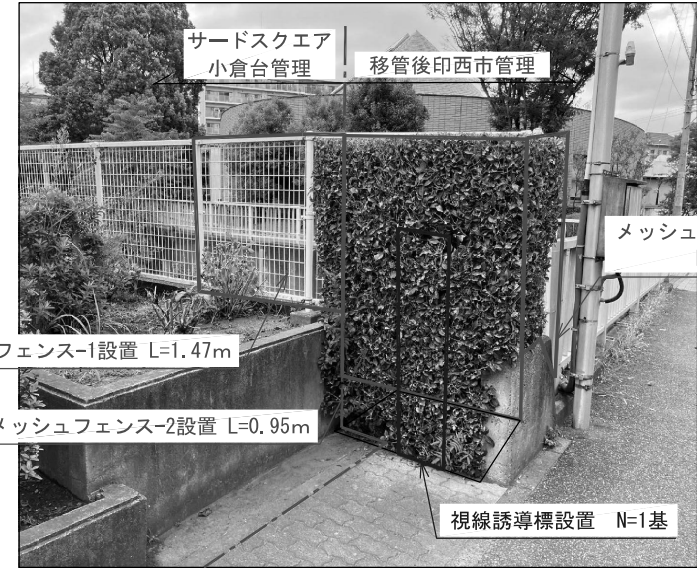
写真③ メッシュフェンス設置
