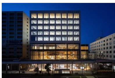
外観(大手通側)
