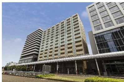
外観（大手通側）
