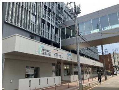
外観(南側)および連絡通路
