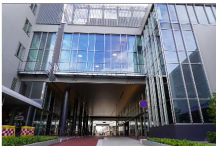
パッサージュ棟・トオリニワ（北側より）
