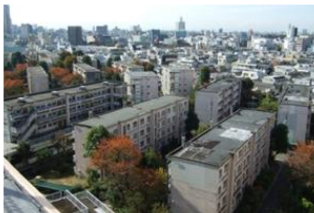
解体前の都営住宅（青山北町アパート）
