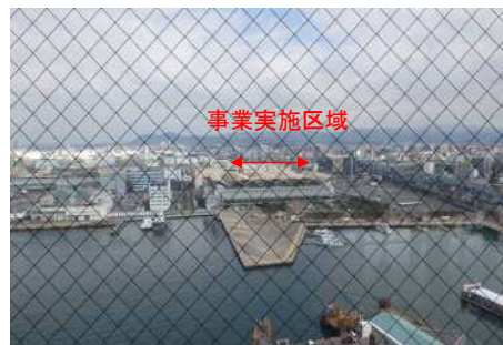
【博多ポートタワー】
