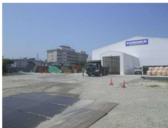
図 1.4-14 仮設洗浄処理プラント
