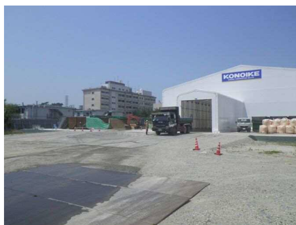
図 1.4-15 仮設洗浄処理プラント
