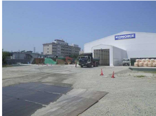
図 2.2-16 仮設洗浄処理プラント
