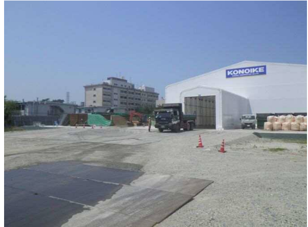
図 1.4-15 仮設洗浄処理プラント
