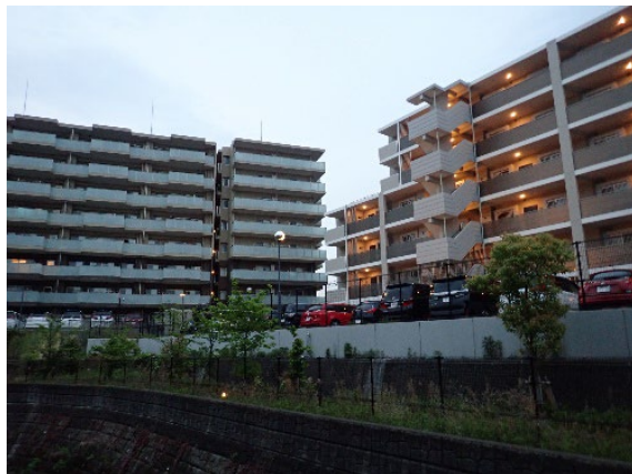
新規住棟の照明状況
