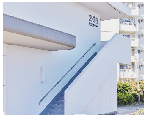
商店街施設棟の外壁
