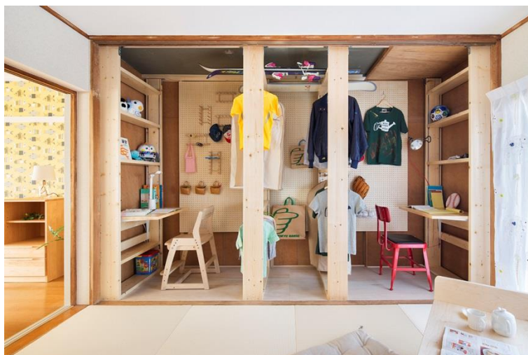
机脇の壁面に有孔ボードを設置
