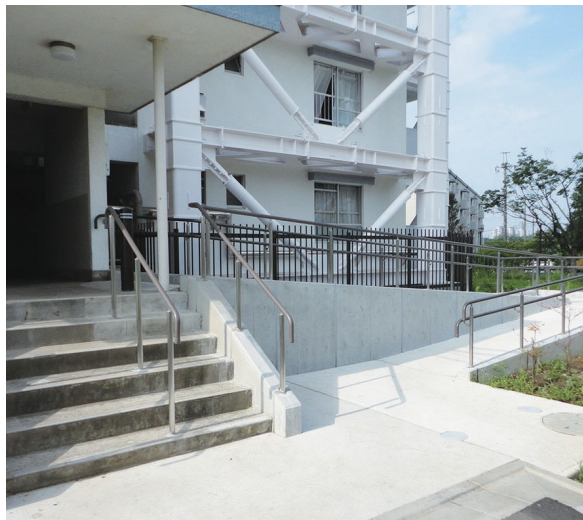
住棟の出入口のスロープ設置 (多摩ニュータウン永山/東京都多摩市)
