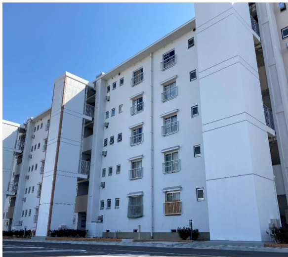
中層住棟に設置したエレベーター (知立/愛知県知立市)
