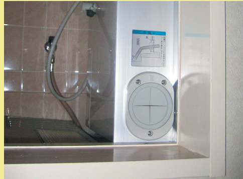
洗濯間接排水設備（建具の場合）
