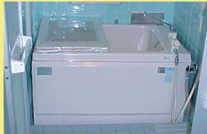
大型浴槽用風呂釜
