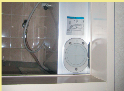
洗濯間接排水設備（建具の場合）
