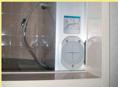
洗濯間接排水設備（建具の場合）
