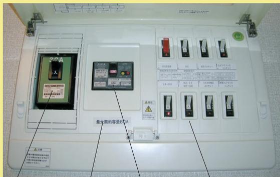
电流限制器 最大可契約電容量 漏电断路器 配线用断路器
