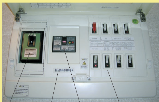
电流限制器 最大可契约电容量 漏电断路器 配线用断路器
