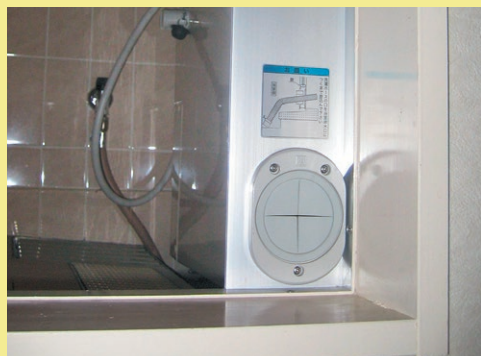
Sistema de drenagem indireta (de porta)
