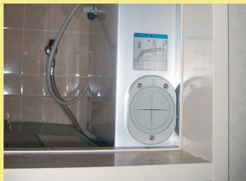
Sistema de drenagem indireta (de porta)
