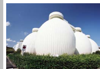
下水汚泥消化施設
