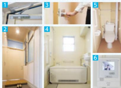
1 ゆっくり閉まるドアクローザー 2 玄関ホールに人感センサー付照明。色彩に配慮した上がりかまち。段差位置に手すりを設置 3 ドアノブのレバーハンドル化 4 浴室内に手すりの設置(3カ所)。またぎ高さを抑えた浴槽。浴室ヒーターの設置 5 トイレに手すりを設置(2カ所)。段差の小さい出入口 6 モニター付インターホンの設置
