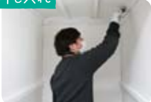
棚板をとり、ペンキを塗っていきます
