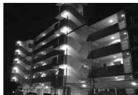
金町第一団地（東京都葛飾区）のLED照明
